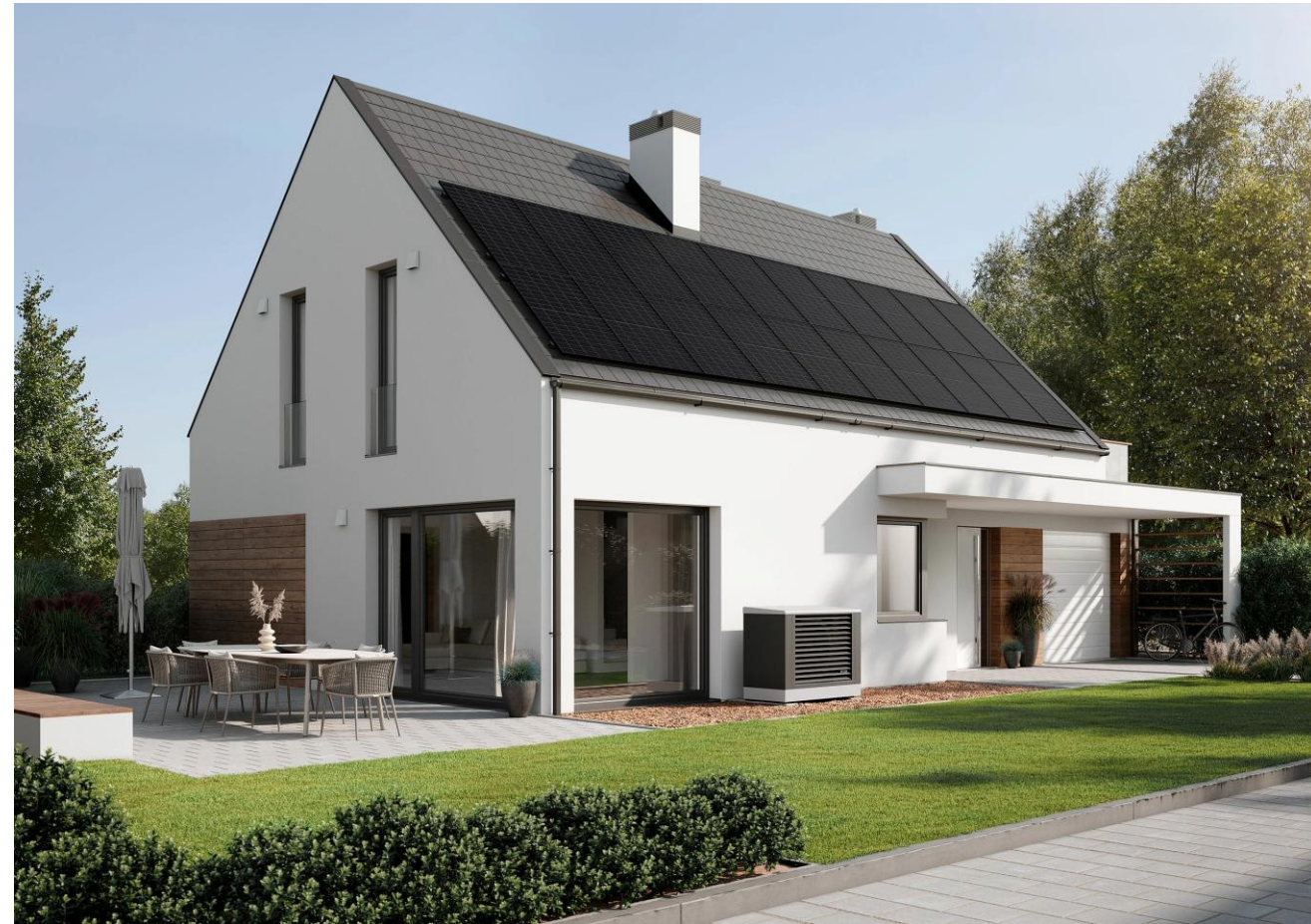
Einfamilienhaus mit PV-Anlage und Wärmepumpe
