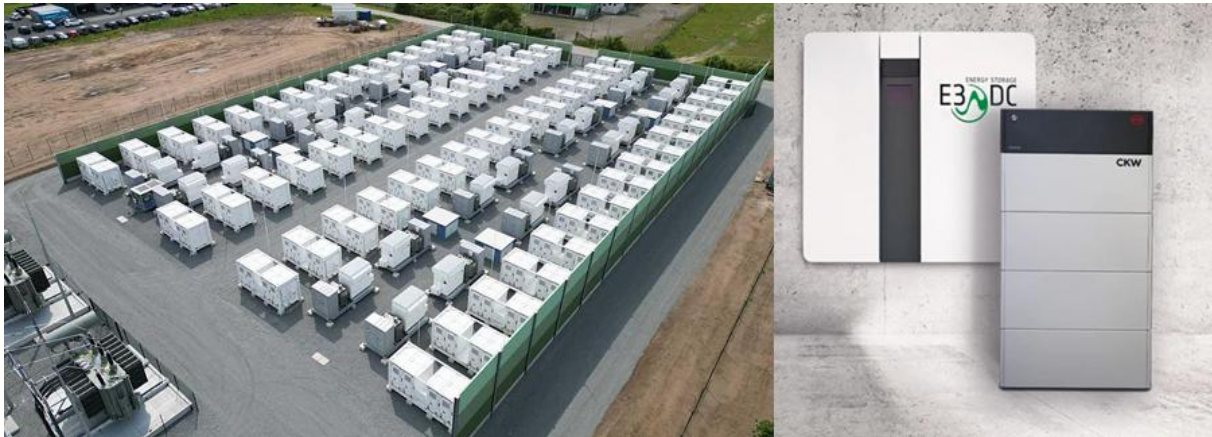
Abbildung 33: Beispiele für Stromspeicher - links Großbatteriespeicher [26] und rechts Hausbatteriespeicher [27]
