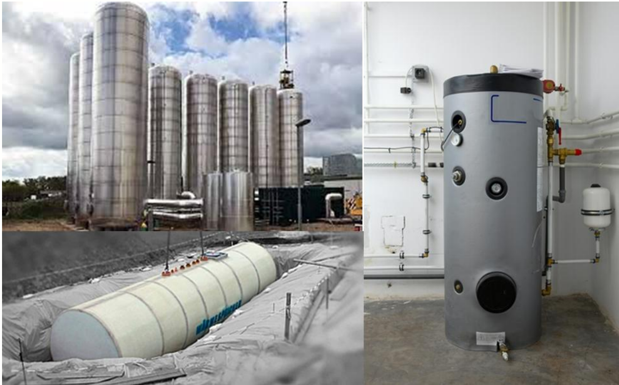
Abbildung 32: Beispiele für Wärmespeicher – links Großwärmespeicher (stehend, oberirdisch oben; liegend, unterirdisch unten) mit bis zu 350 m 3 [24], rechts Pufferspeicher für Einfamilienhäuser (1 m 3 ) [25]
