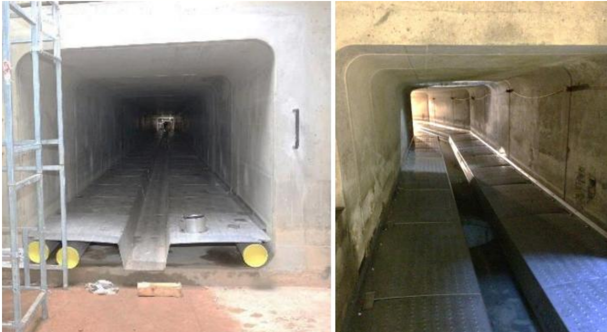
Abbildung 31: Wärmeübertrager im Abwasserkanal [23]
