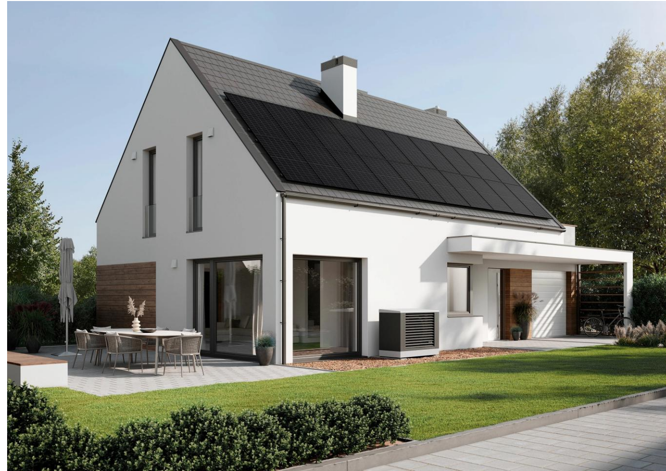
Einfamilienhaus mit PV-Anlage und Wärmepumpe
