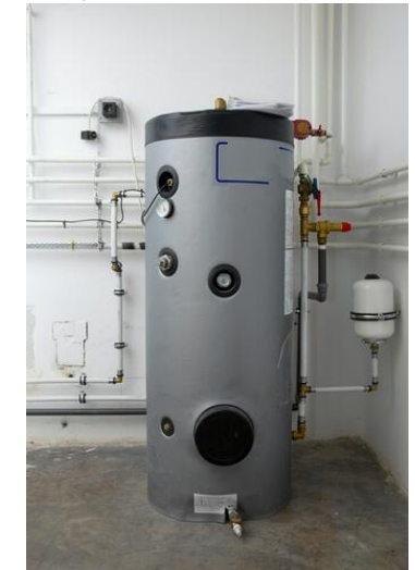
Pufferspeicher Haushalt typisch z.B. 1 m 3
